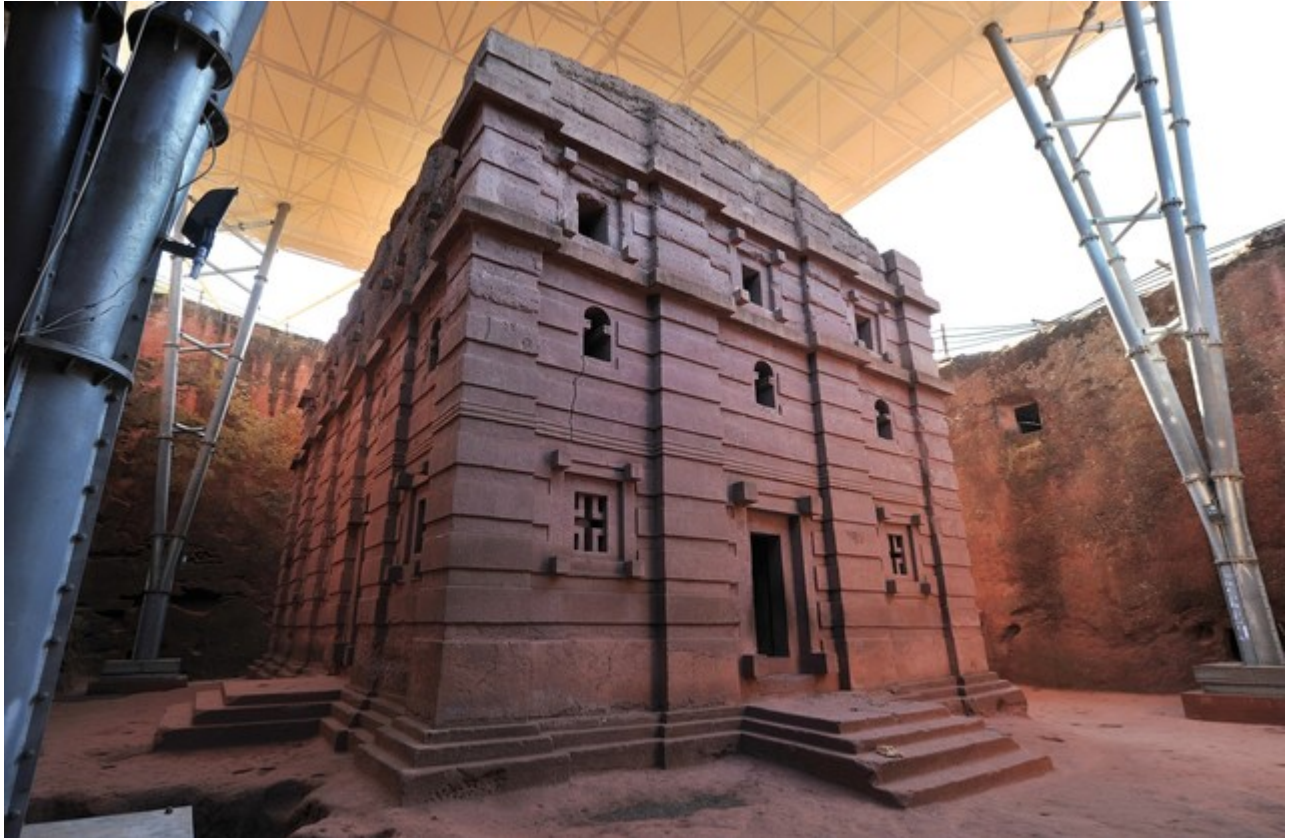
L'un des toits installés pour protéger certaines églises de Lalibela, ici Bet Amanuel
